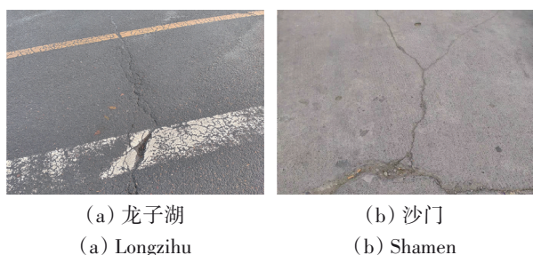
图3 地铁站点附近地裂缝
